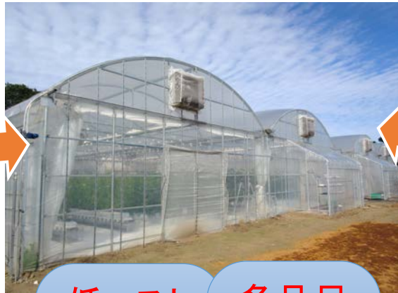
従来より太いパイプの採用と2重被覆構造
